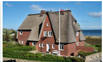
Sanierung eines Doppelhauses
